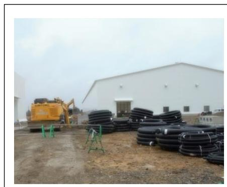
電線ケーブル埋設用のフレキシチューブ
